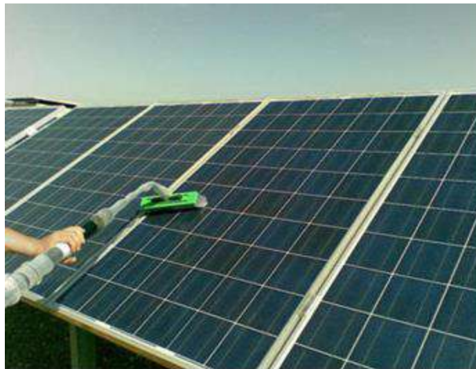
Foto 6.3.3-1. Forma de limpieza de los paneles solares.
