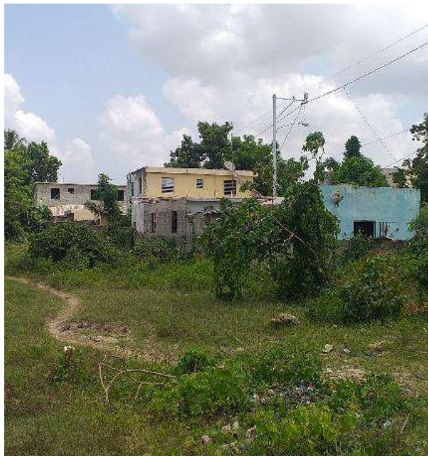
Foto 2.6.1-2. Foto desde dentro del terreno del proyecto hacia la pared. Foto tomada por EMPACA, 2 de septiembre 2021.
