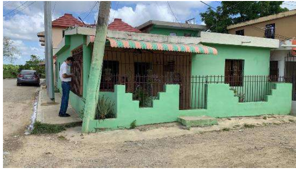
Foto 3.4.5.5-2.- Vivienda en Guerra. Foto tomada por EMPACA, 7 de septiembre 2021.
